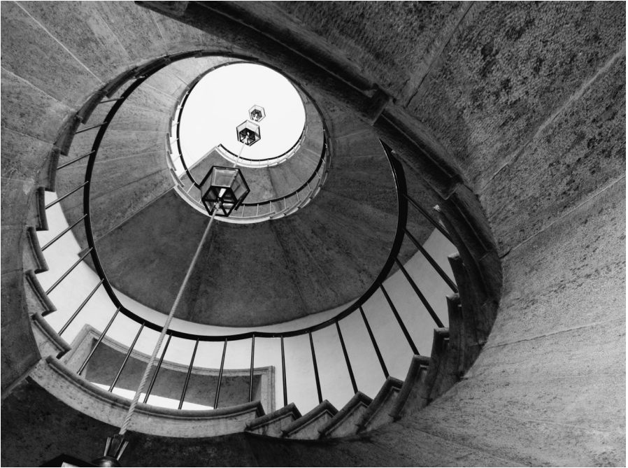
Wilhelmstraße 9, Altbau, Treppenhaus.
