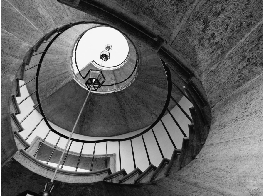
Wilhelmstraße 9, Altbau, Treppenhaus.
