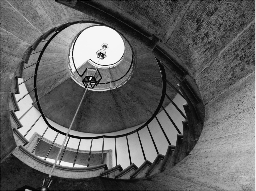
Wilhelmstraße 9, Altbau, Treppenhaus.
